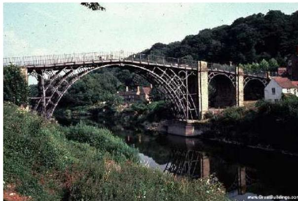
**Figura 1.7: Ponte de ferro fundido em Coalbrookdale/Severn**
